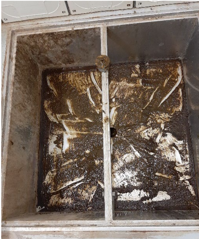
Figuur 3 Mestopslagput met rundveedrijfmest waaruit de meeste 'oude' mest is verwijderd om een bevuilde vloer na te bootsen. Hierop is vervolgens de verse mest aangebracht waarna de emissiemetingen zijn gestart.
